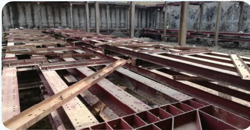
H型钢作为受力梁及H型钢支撑梁等组成，立柱、对撑、角撑、横梁、拉杆、三角形接点、预压顶紧装置等标准部件组合并施加预应力，形成平面预应力支撑系统与立体结构体系。钢绞线和钢桁架组成的装配式预应力鱼腹梁，通过钢绞线施加预应力，传递给鱼腹梁支撑钢杆件产生的反作用力，使鱼腹梁围檩弯矩作用有效减少，从而降低了鱼腹梁的弯曲变形。大跨度预应力鱼腹梁钢支撑改善了挖土、运土及地下结构施工，提供了开阔的施工作业条件。
