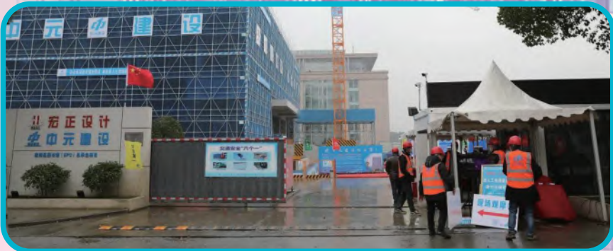
工地大门美观大方
