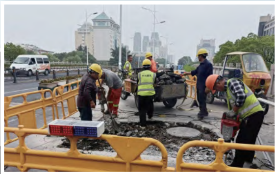
市政分公司道路养护班组高温下开展路面养护
