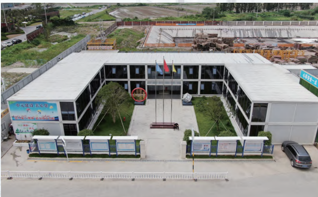
项目部办公区美观大气
